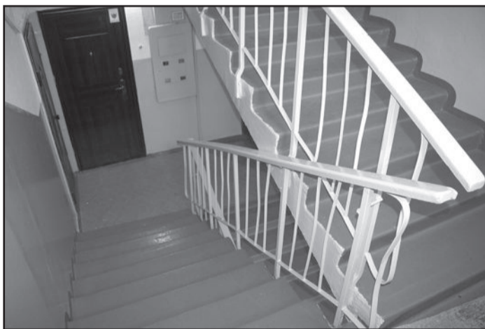
Потолок побелен, стены оштукатурены и покрашены. Вот так выглядят подъезды в доме №3а на бульваре Рябикова после проведенного здесь текущего ремонта.
