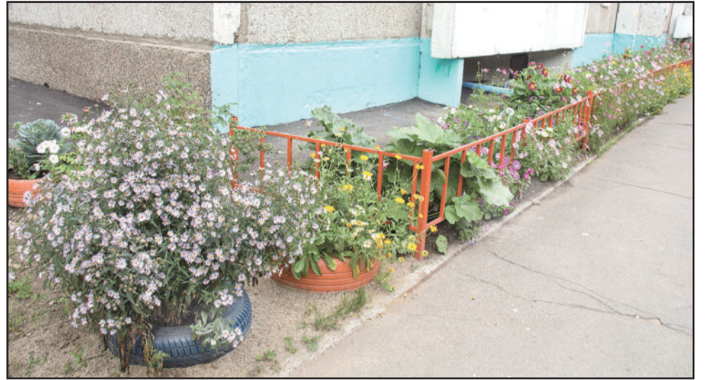
За яркими цветами не сразу и замечаешь выкрашенный цоколь и новую отмостку в доме №105 мкр. Университетского.
