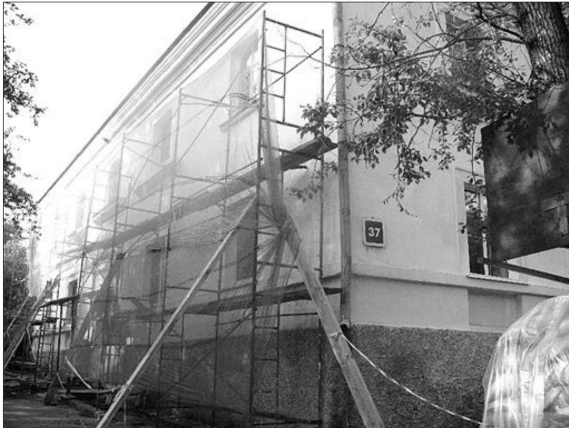
В этом двухэтажном доме подрядчики будут обновлять и подвал, и крышу. Но это та работа, которую не видно снаружи. А вот отремонтированный фасад заметят все. Со стен уже сняли старую краску и оштукатурили их. На общем собрании собственники решили, что подрядчики покрасят фасад их дома в теплый персиковый цвет.
