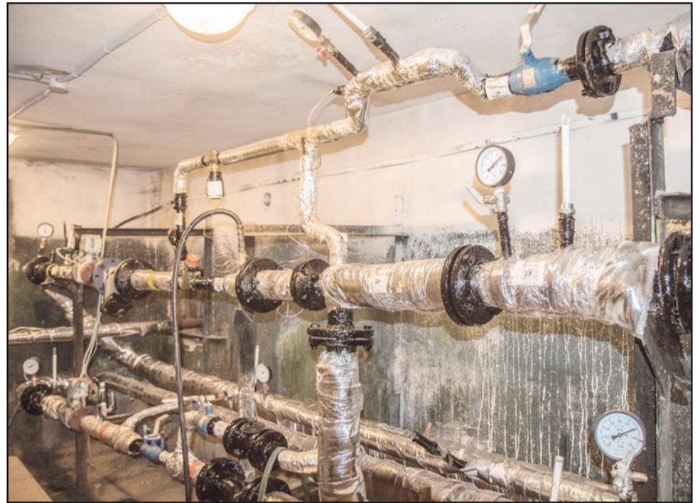
**Трубы в подвале должны быть покрыты изоляционным слоем. Сейчас для этих целей используется современный материал термофлекс, который надежно защищает коммуникации от коррозии**
